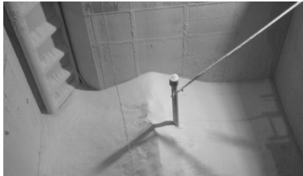
Канал контроля в технологической шахте
