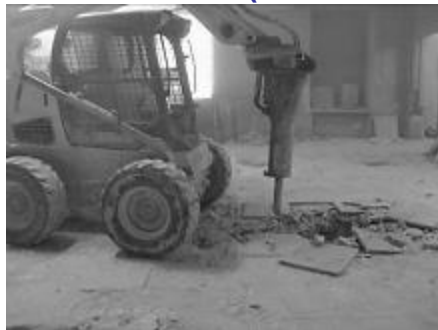
Проходка через перекрытие вне реакторных помещений
