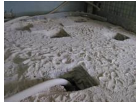
Проходка через перекрытие вне реакторных помещений
