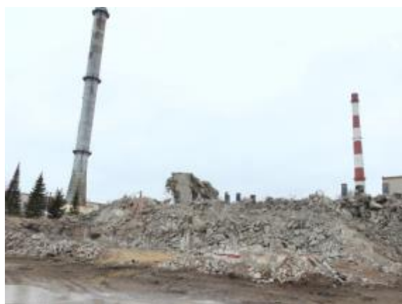
Демонтаж строительных конструкций центрального зала
