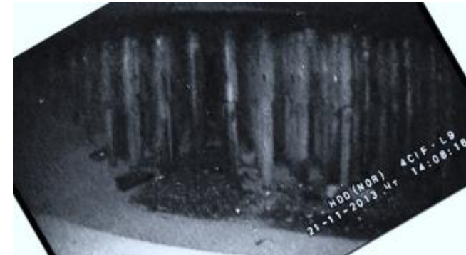
Полость между нижними металлоконструкциями
