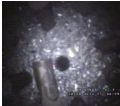
Проходка через металлоконструкции нижней биологической защиты (схема «Р»)
