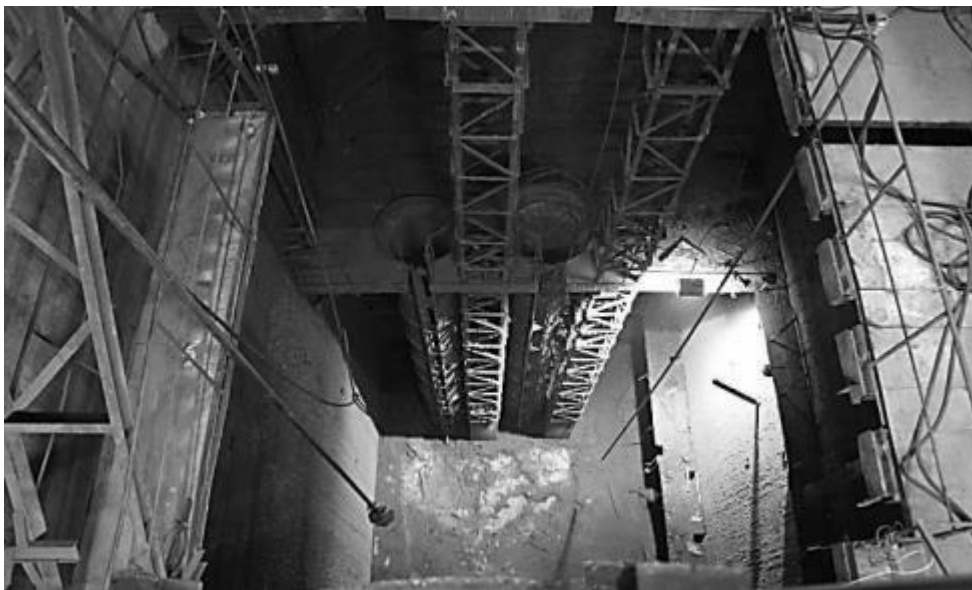
Начальная стадия демонтажа металлоконструкций
