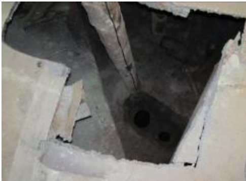
Проходка через металлоконструкции верхней биологической защиты (схема «Е»)
