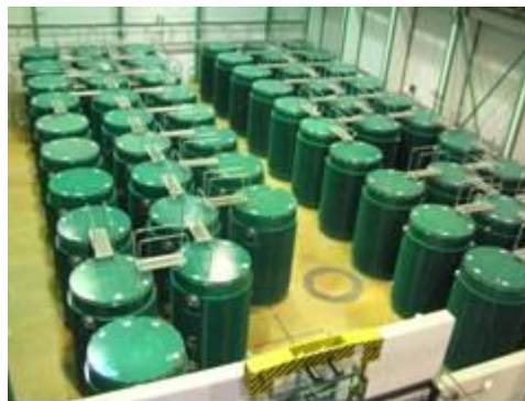
Пристанционное контейнерное хранилище ОЯТ на АЭС «Дукованы» (Чехия). Контейнер CASTOR®-WWER-440.
