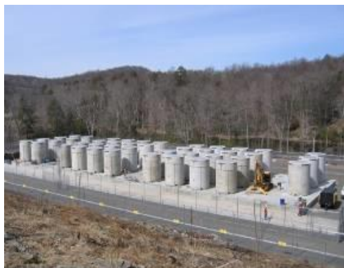
«Сухое» контейнерное ХОЯТ на АЭС Maine Yankee (США). Бетонный контейнер VVC.
