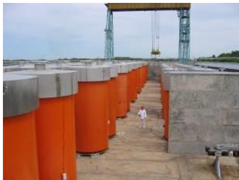
«Сухое» контейнерное ХОЯТ на Игналинской АЭС (Литва). Контейнер CONSTOR®-RBMK-1500.
