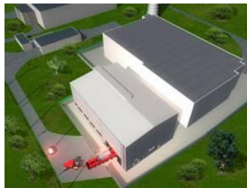
Пристанционное контейнерное ХОЯТ на АЭС «Козлодуй» (Болгария). Контейнеры CONSTOR®-WWER-440 и CONSTOR®-WWER-1000.
