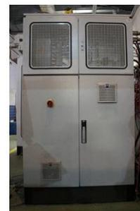
Шкаф системы управления и газоподготовки
